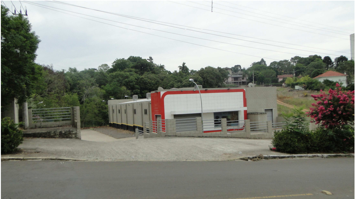
Foto 1: Detalhe da fachada do imóvel a partir da Av. Presidente Lucena
